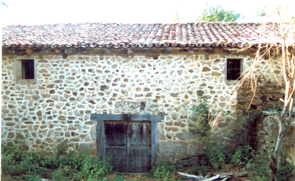
Edificio del molino harinero y serrería
