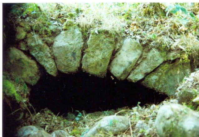
Canal de conducción de agua para las fábricas. Finca "Los Llecós".
