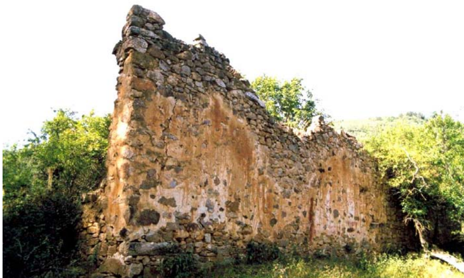
Paredes del lavadero de lanas
