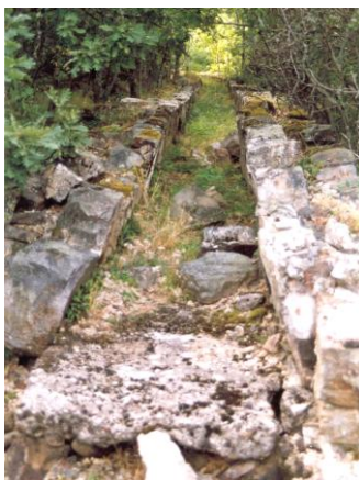
Canal de conducción de agua
