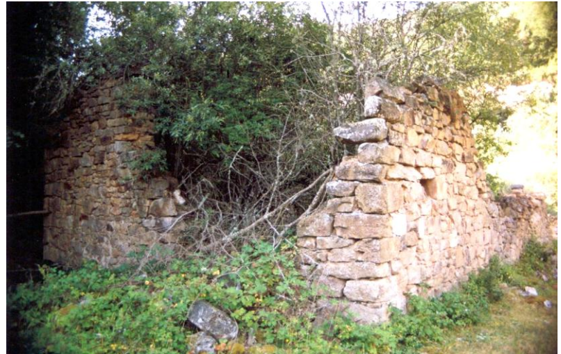
Restos del edificio serrería, junto al puente de las Aceñas
