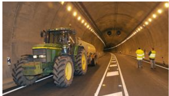
Túnel Piqueras- Foto de Valentín Guisande
